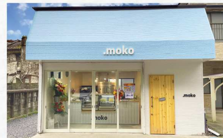
店舗 改修工事
