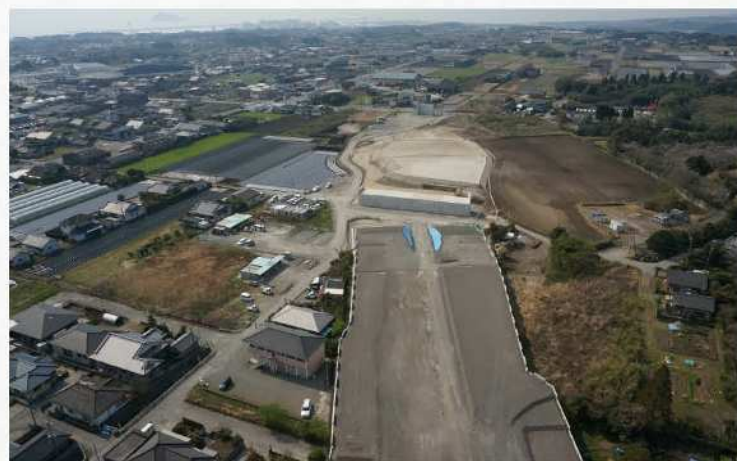
道路改築工事
