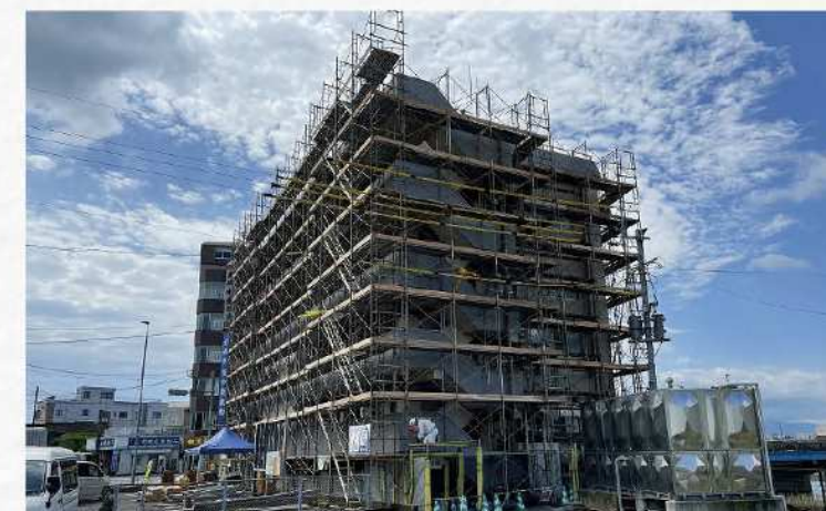
ビル外壁改修
