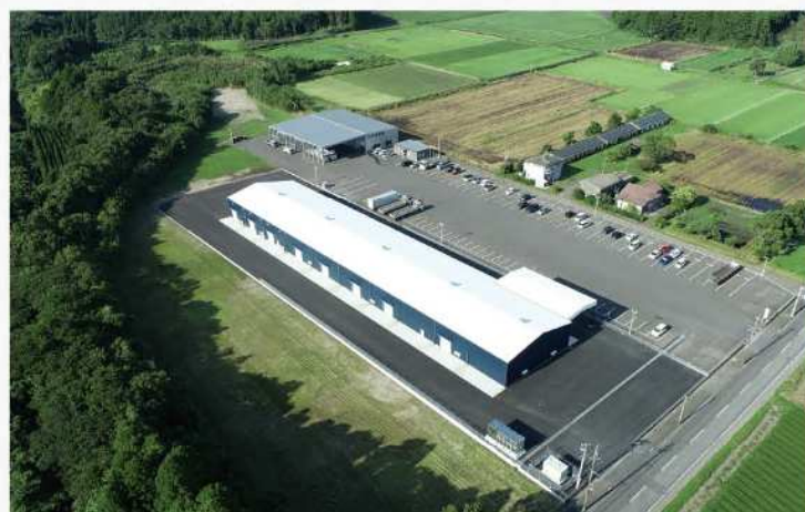
アスファルト舗装
